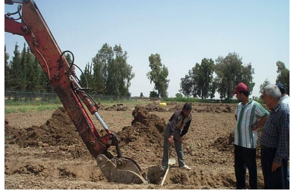
حفر خندق للعمق المطلوب
